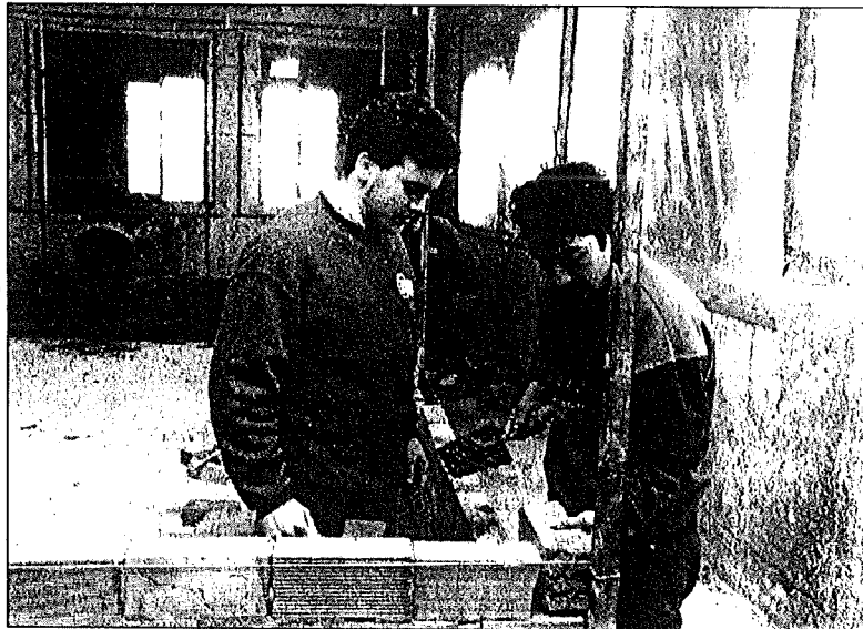
Los trabajos de albañilería se desarrollan en el Palacio del Gobernador.
